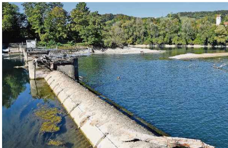
Geprüft wird, ob das Dachwehr dereinst entfernt werden kann.
